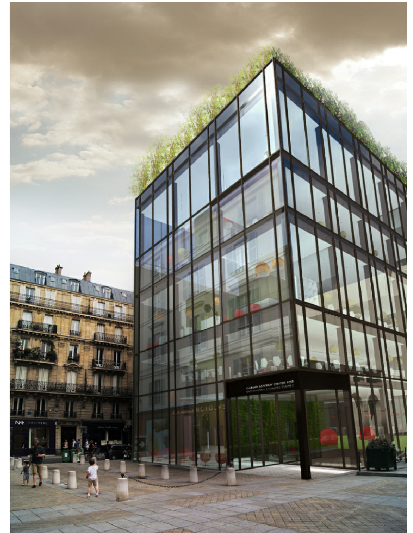
severna fasada z vhodom
